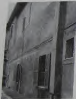
Fig. 11. SS. Quattro Coronati. South aisle wall, exterior.
